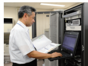
運用マニュアルで、導入当初の不安も解消。当初から安定稼働を実現している。
